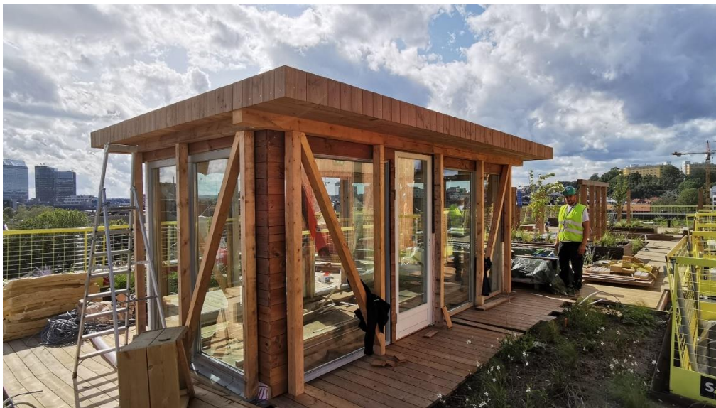
Takstue på nybygg i Nordre gate, bygget av ombruksmaterialer. Bilde: Resirqel
