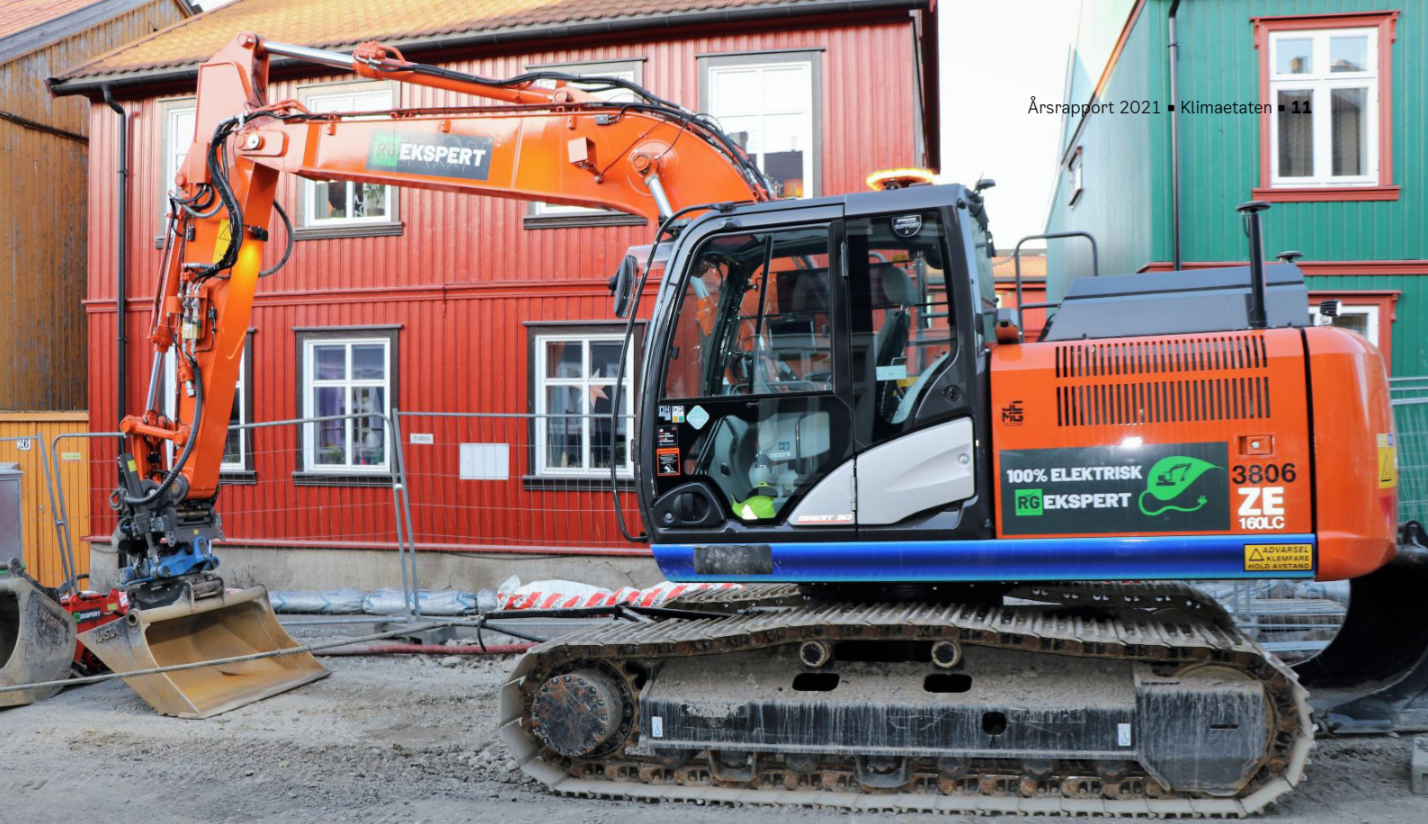
Dette er en elektrisk gravemaskin på en utslippsfri byggeplass på Vålerenga. Foto: Nils Gelting Andresen, Klimaetaten
